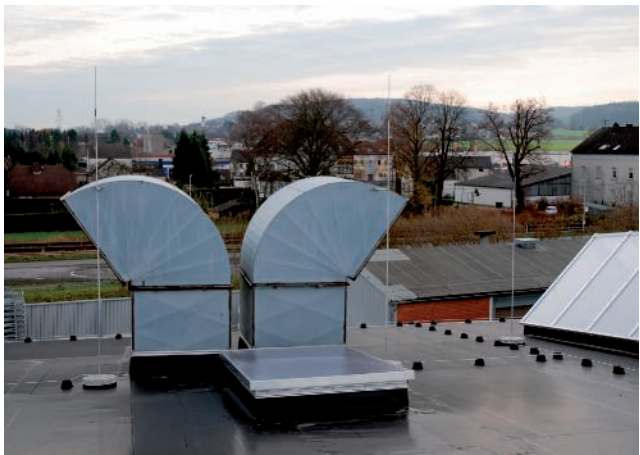
Sistema isolado com suportes GFK
