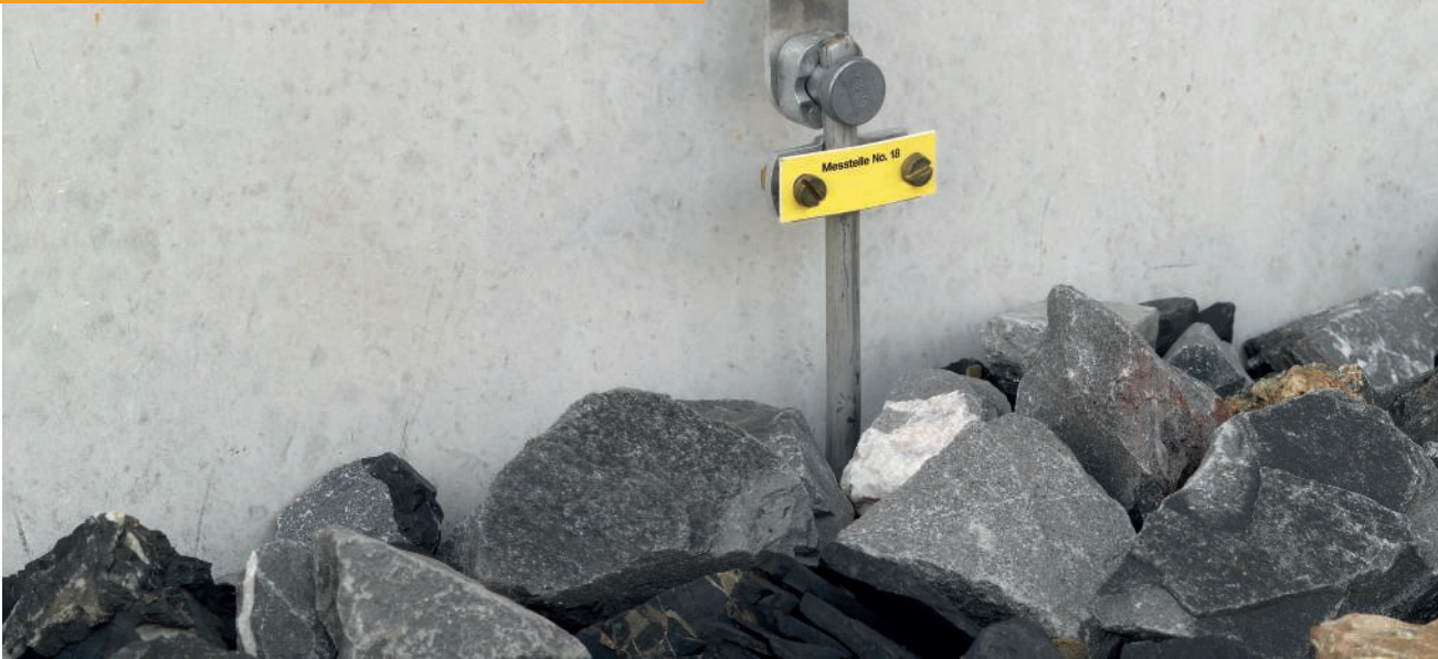
Ponto de medição na entrada da terra
