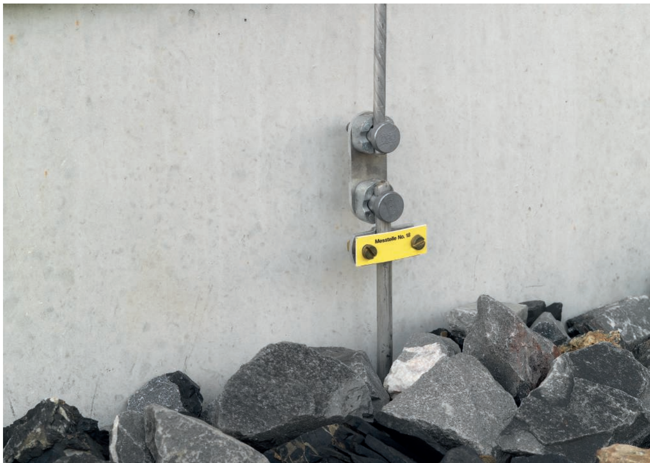
Ponto de separação numa fachada metálica
