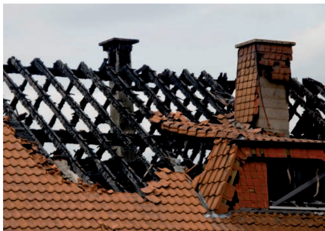
Danos em edifícios por incidência direta de um raio.
