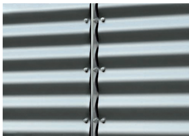
Exemplo: Uso de elementos de fachada conectados horizontalmente como dispositivo de descarga
