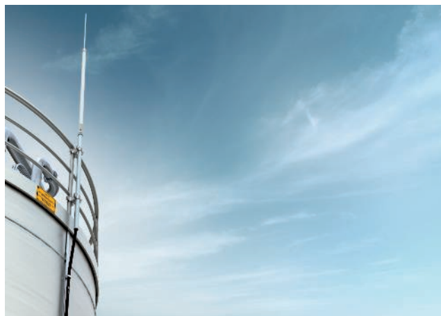
Proteção isolada contra raios com isCon®
