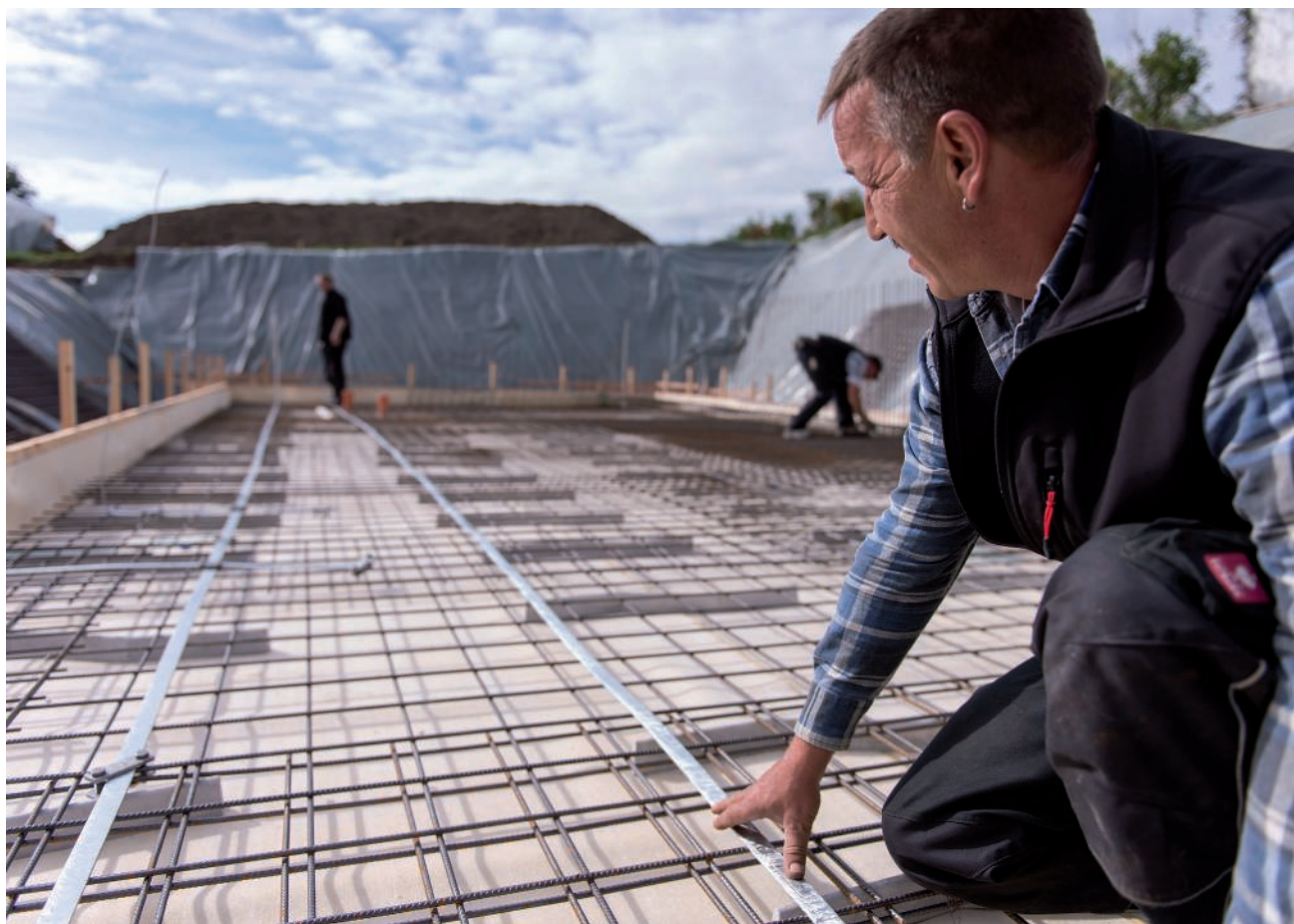
Colocação de um elétrico de terra de fundações
