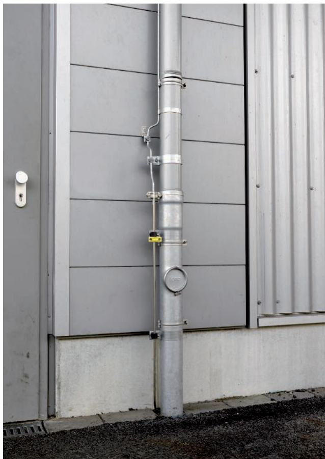
Condutor de proteção contra raios em tubo de descida
